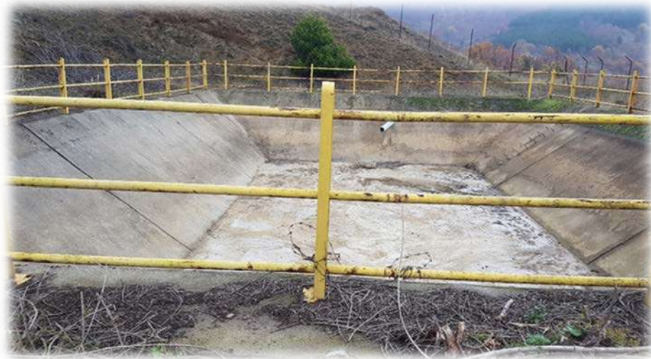
Εικόνα 11 – Σκυροδετημένη υδατοδεξαμενή Περιοχή Καστοριάς (Προσωπικό Αρχείο)
