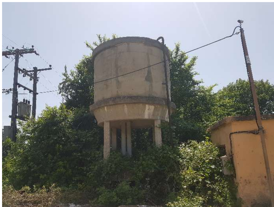
Εικόνα 12 – Υδατόπυργος στην περιοχή των Γιαννιτσών Θεσσαλονίκης
