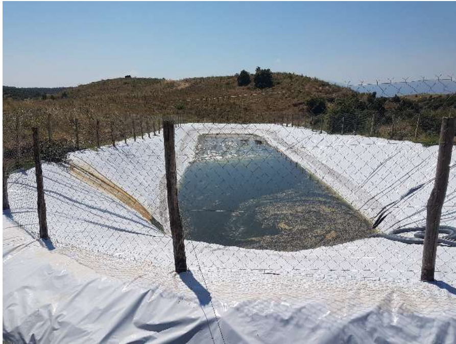
Εικόνα 13 - Πλαστική ομβροδεξαμενή στην περιοχή Λαγκαδά, Θεσσαλονίκης
